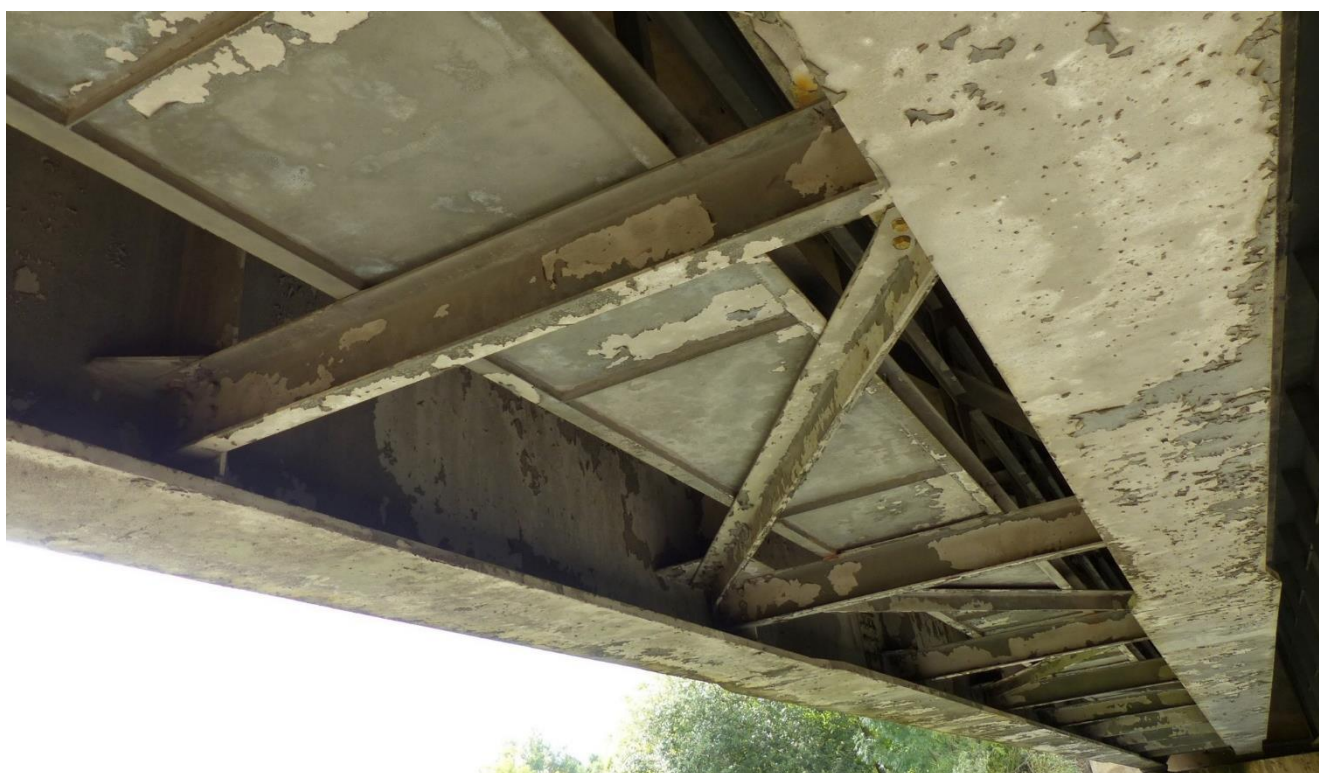
Foto 9 a 10: Most v km 205,175, nevyhovující stav opěry mostu a ocelové nosné konstrukce.
