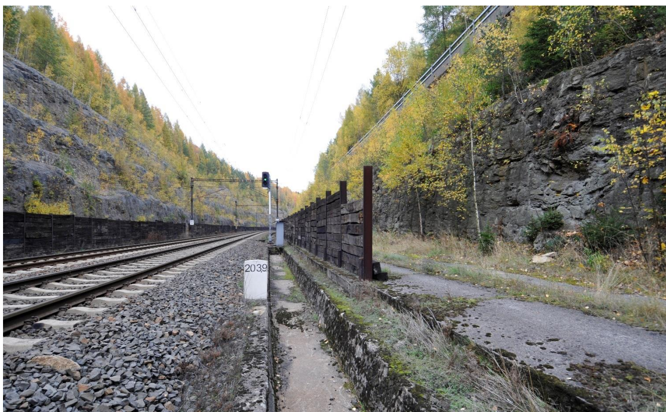
Foto 4: Erodující svah zářezu v km cca 203,500, v němž jsou navrženy úpravy stávajících, případně nová sanační opatření.
