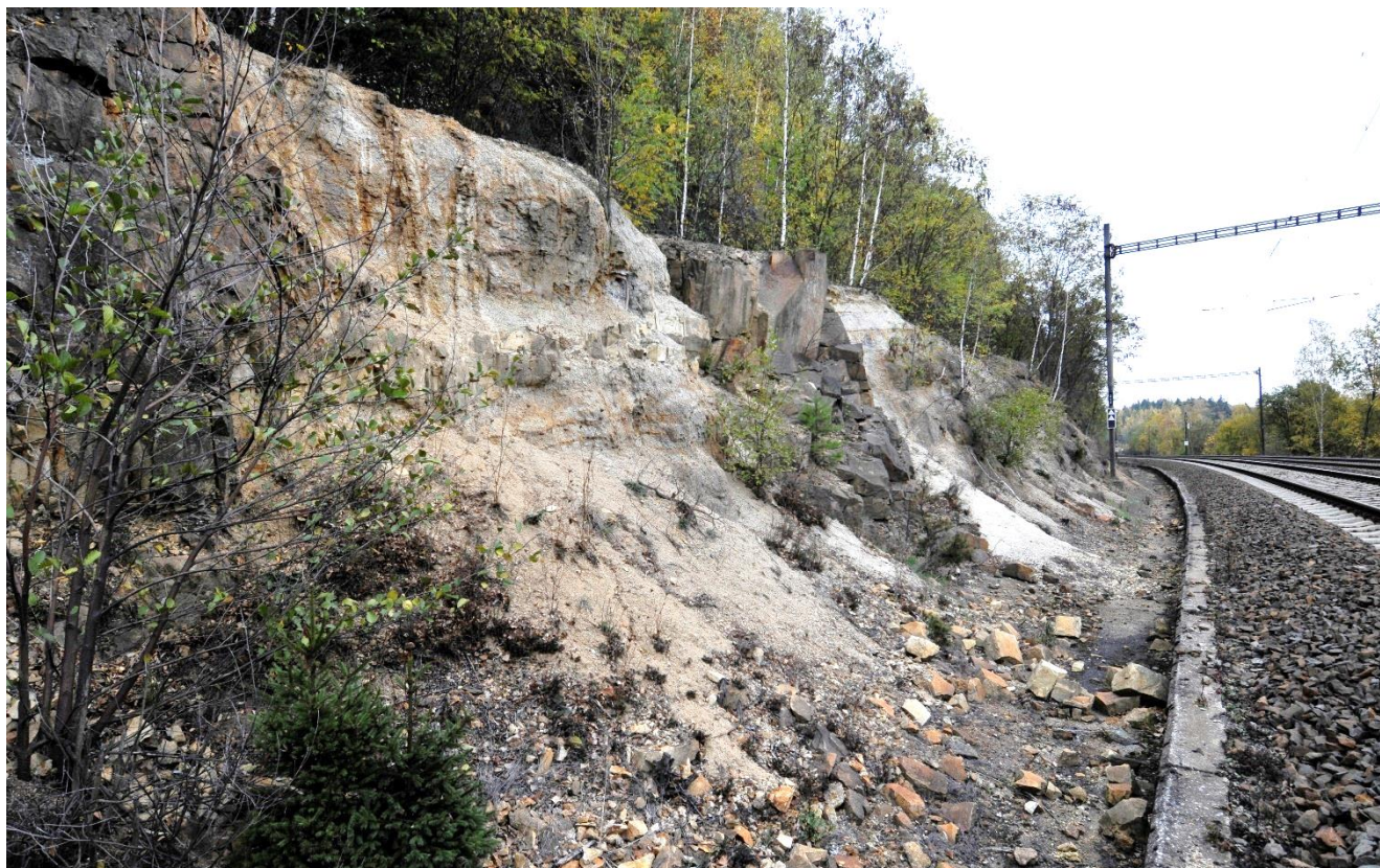
Foto 3: Erodující svah zářezu v km cca 204,800, v němž jsou navržena sanační opatření.
