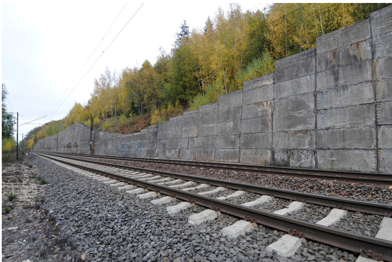
Foto 5 a 6: Zárubní km 204,190 - 204,480, která není v havarijním stavu a je navržena jen nejnutnější potřebná sanace.
