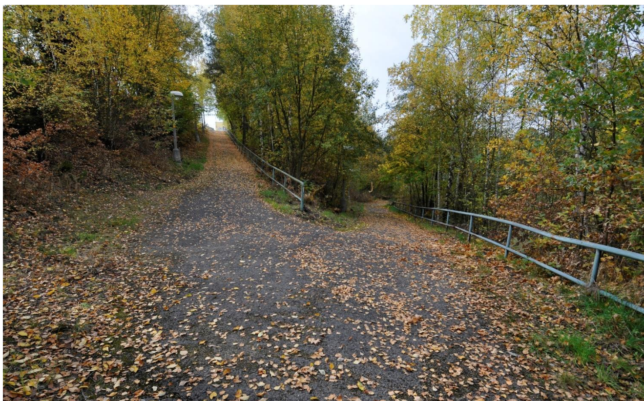
Foto 2: Přístup na zastávku Královské Poříčí, sklon chodníků je místy až 15% (normou povolený sklon pro přístupových chodníků je maximálně 8,33%)
